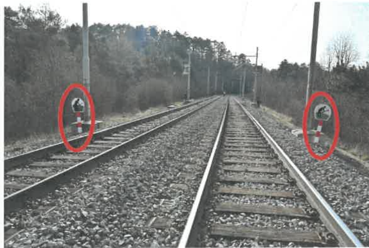
Slika št. 2: Z rdečima elipsama sta označena progovna opozorilnika, ki sta bila iz smeri Postojna pravilno nameščena na vsaki strani proge.
