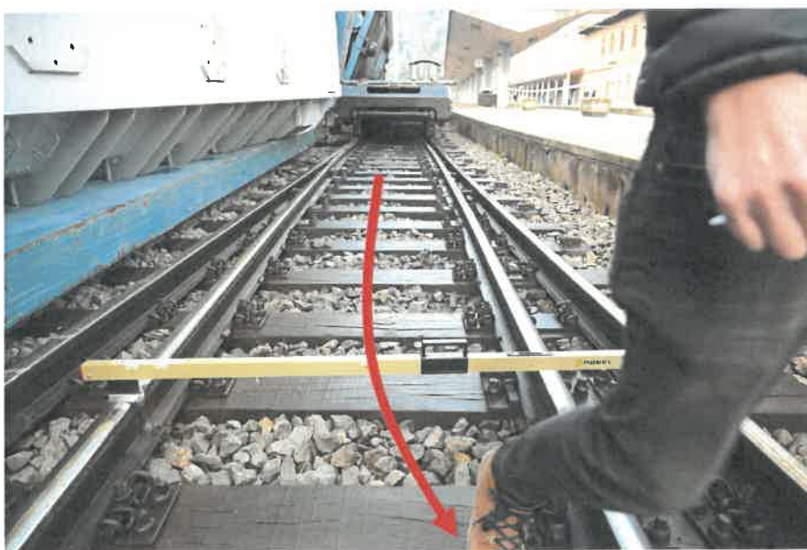
Slika št. 11: Z rdečo puščico je označena smer vožnje vlaka št. 47488 preko kretnice št. 14 postaje Zidani Most.
