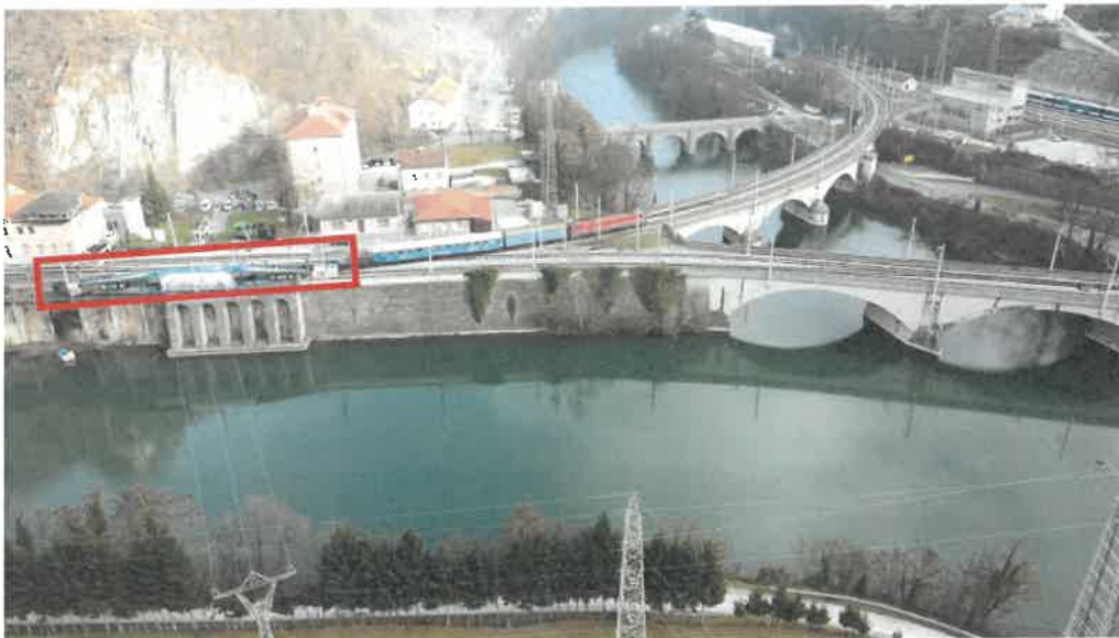
Slika št. 4: Prikaz infrastrukture na območju nesreče z dvema zidanima mostovima preko katerih potekajo železniški tiri. Z rdečim pravokotnikom je označena na bok prevrnjena nosilna konstrukcija vagona z vpetim elektro transformatorjem mase 290 t.
