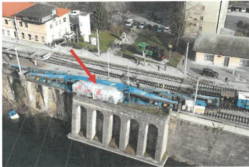
Slika št. 3: Rdeča puščica na fotografiji prikazuje na bok prevrnjeno nosilno konstrukcijo 32 osnega Uaai vagona z elektro transformatorjem ob kretnici št. 14 postaje Zidani Most.
