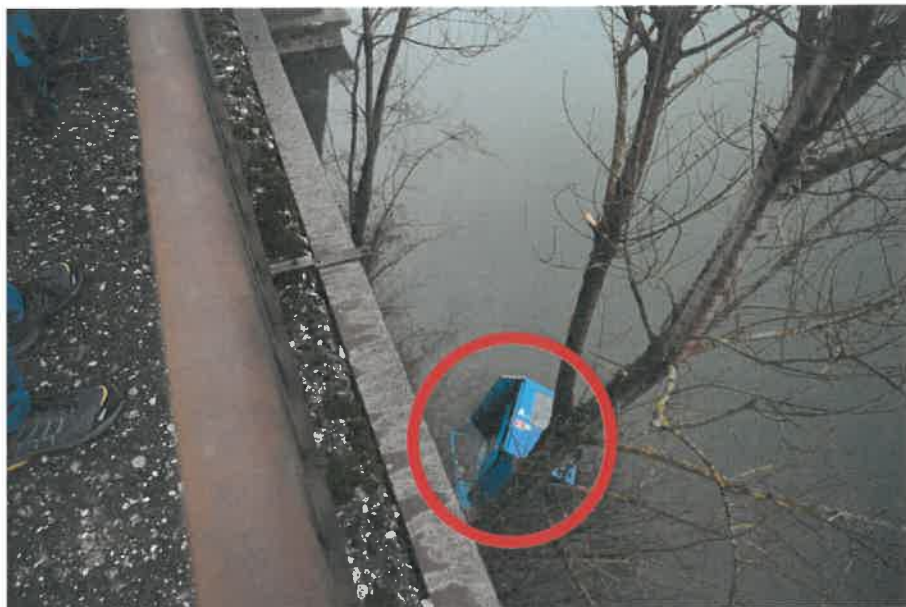
Slika št. 17: Rdeč krog prikazuje kabino št. 2, ki se je med zvrčanjem kljunastega nosilnega elementa odtrgala od njega in zgrmela ob opornem zidu tira št. 3 postaje Zidani most na brežino reke Save.
