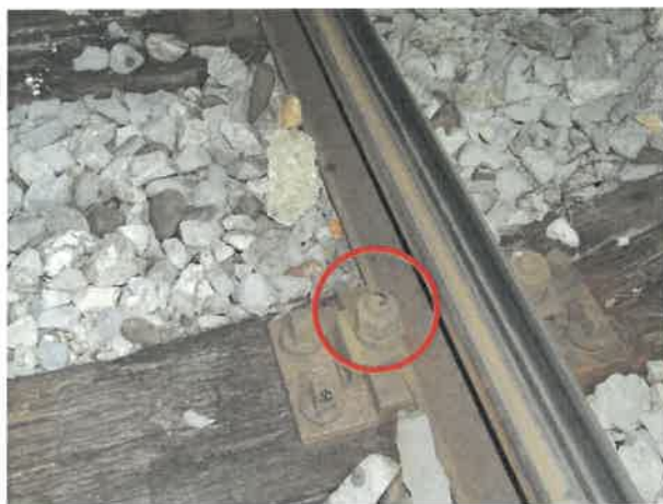
Slika št. 10: Z rdečim krogom je označen pritrdilni vijak tirnice, na vrhu katerega so vidne sledi svežega udarca. Ta točka je bila vzeta kot referenčna točka iztirjenja.
