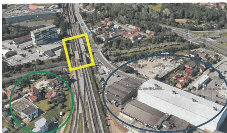
Slika št. 3: Z rumenim pravokotnikom je označeno postajališče Maribor Tezno, z modro elipso so označeni gospodarski objekti z zelenim krogom pa stanovanjsko naselje v neposredni bližini
