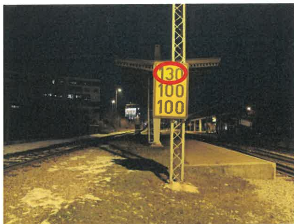
Slika št. 19: Rdeč romb označuje hitrost za vlake z nagibno tehniko na signalnem znaku št. 33, ki je pritrjen na drogu vozne mreže v km 591.206.
