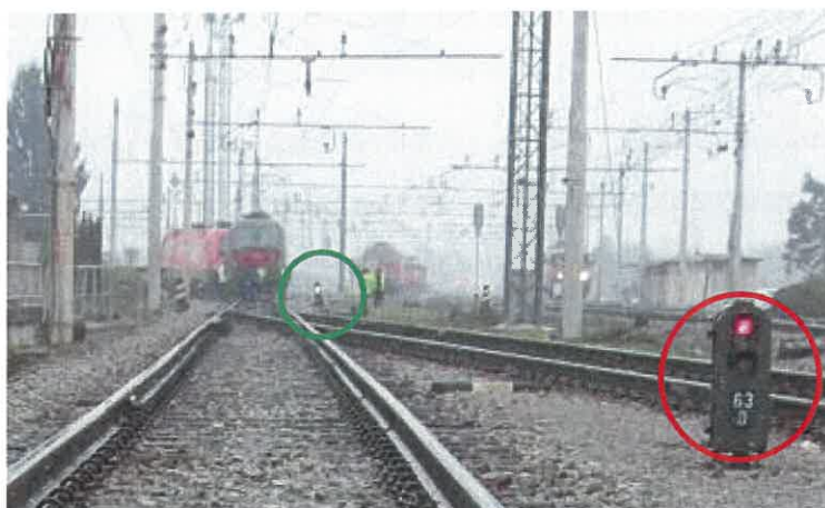
Slika št. 7: Zeleni krog označuje premikalni signal 60V, ki kaže signalni znak št. 28: »Premik dovoljen« rdeča pa označujeta premikalna signala 63D, ki kaže signalni znak št. 28: »Premik prepovedan«.
