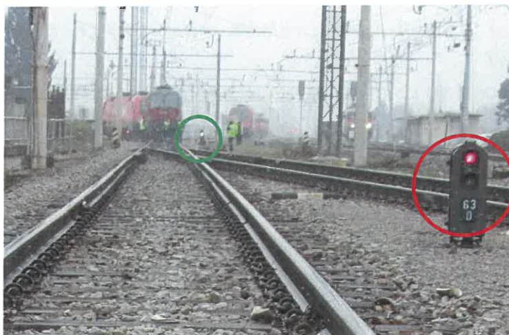
Slika št. 4: Prikazuje premikalno pot za vožnjo premikalnega sestava - v rdečem krogu premikalni signal 63D na tiru 504, ki kaže signalni znak št. 28: »Premik prepovedan«, v zelenem krogu pa premikalni signal 60V na tiru 404, ki kaže signalni znak št. 29: »Premik dovoljen«.
