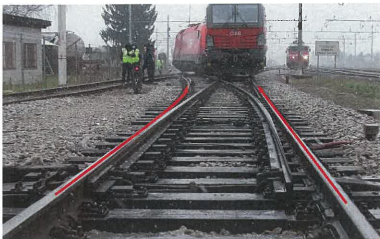
Slika št. 5: Rdeči puščici prikazujeta smer vožnje koles druge osi prvega podstavnega vozička E-lok 1116-025.
