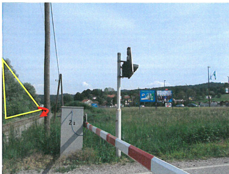
Slika št. 18: Rdeča puščica prikazuje smer vožnje vlaka, rumeni trikotnik pa vegetacijo – drevesa, visoko grmovje, ki zastira preglednost na nivojski prehod iz ljubljanske smeri proge.
