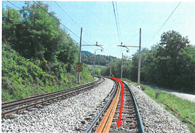
Slika št. 25: Rdeča puščica prikazuje potek proge neposredno pred kretnico št. 1.
