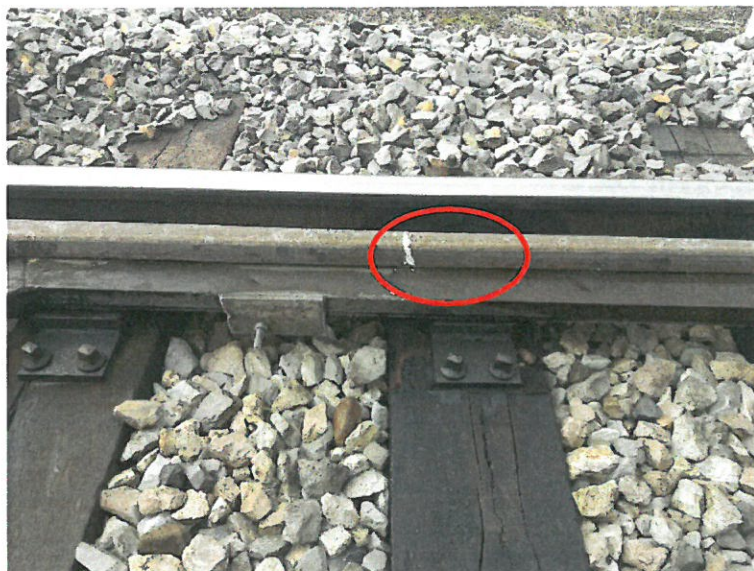
Slika št. 24: Označevanje točk profilov na tirnicah
