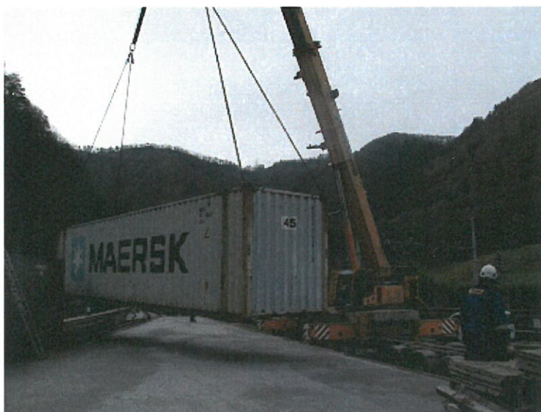
Slika št. 6: Razložitev kontejnerjev iz iztirjenega vagona
