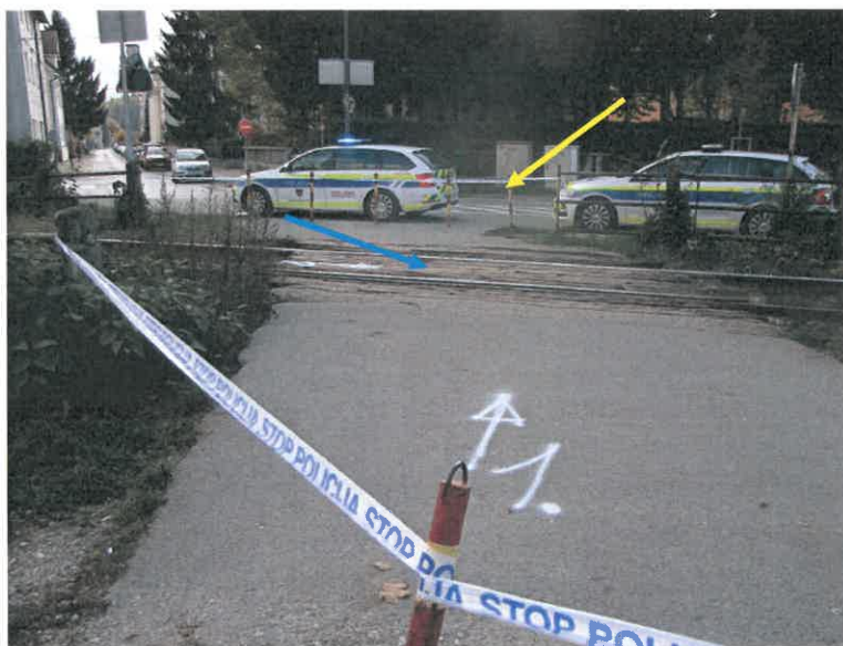
Slika št. 8: Prikaz cestne infrastrukture na nivojskem prehodu, rumena puščica označuje pokončne kovinske stebričke, modra pa lesene pragove na prehodu.
