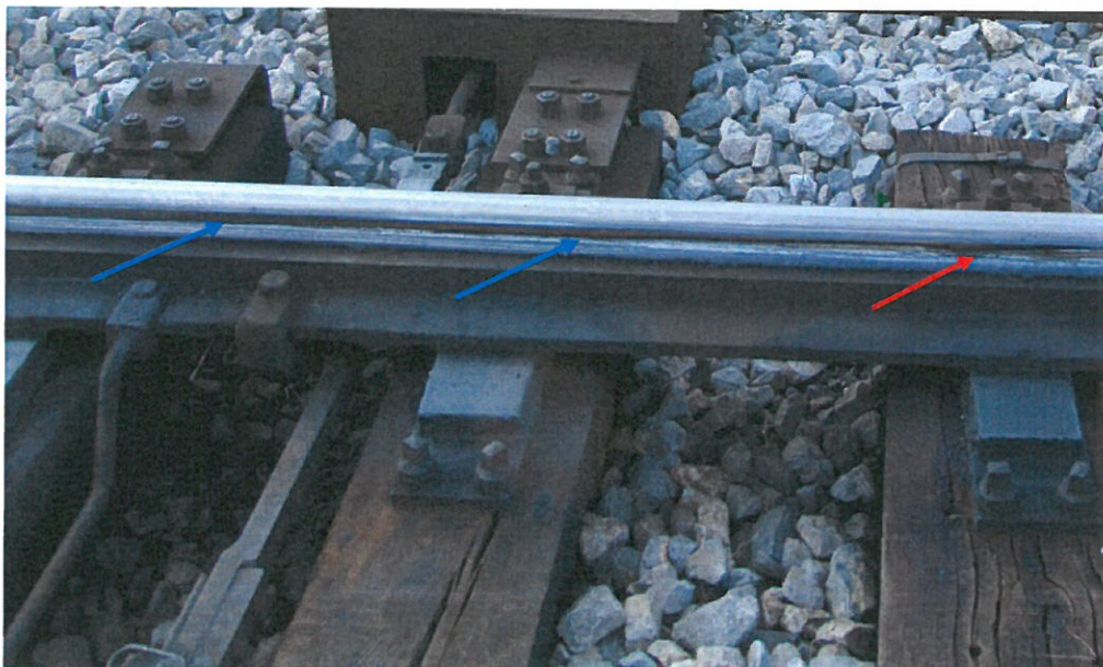
Slika št. 4: Z modro puščico sta označeni točki močno izrabljene ostrice z rdečo pa točka izrabljene ostrice na mestu naplezanja kolesnega venca.
