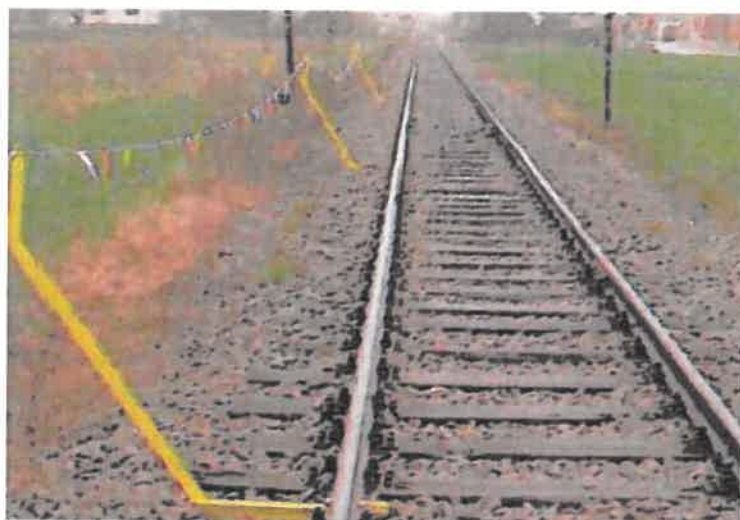
Slika št. 5: Prikaz varovanja delovišča kot ga predpisuje točka 2.7. Način zavarovanja – Delo na železniškem območju, Elaborat, Varnostni načrt
