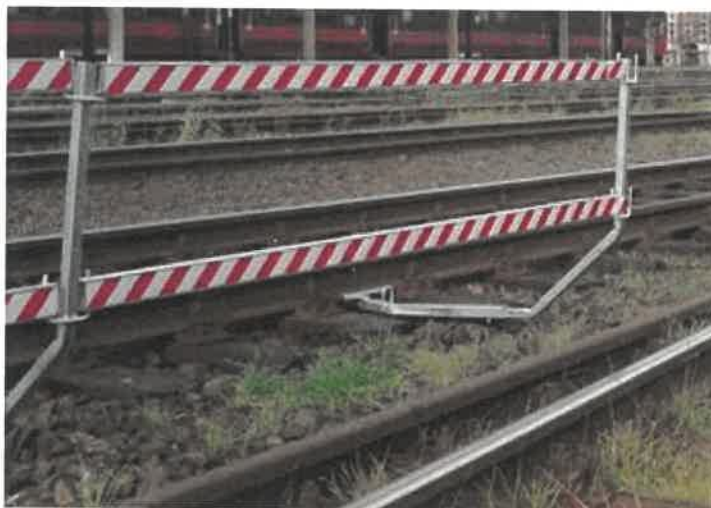
Slika št. 6: Prikaz varovanja delovišča s sodobno varovalno ograjo
