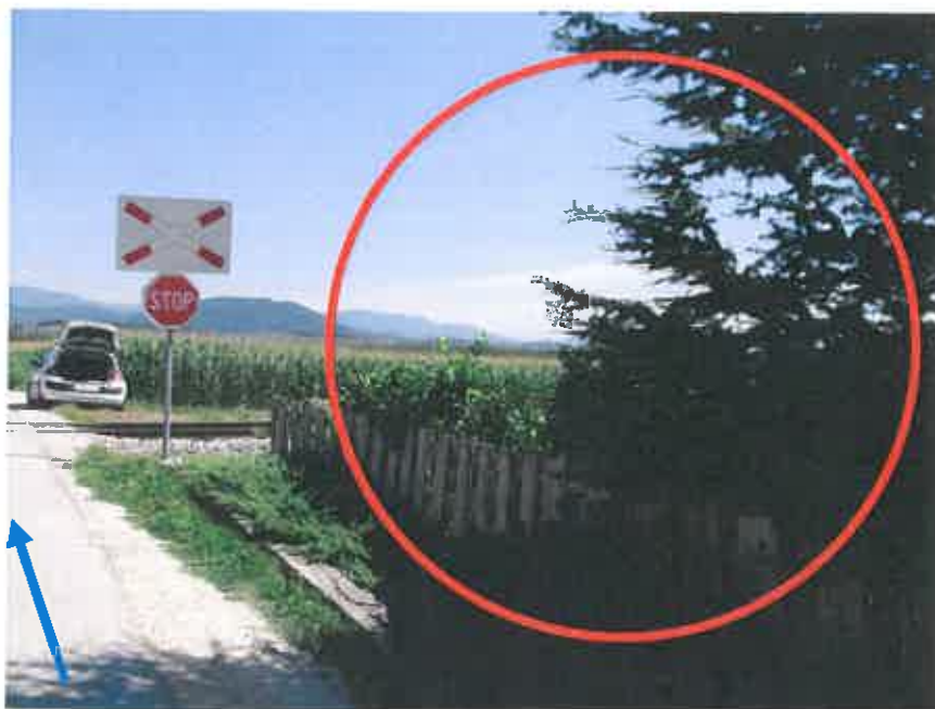
Slika št. 4: Rdeča elipsa prikazuje vegetacijo ob cestišču pred nivojskim prehodom, modra puščica pa smer vožnje cestnega osebnega motornega vozila
