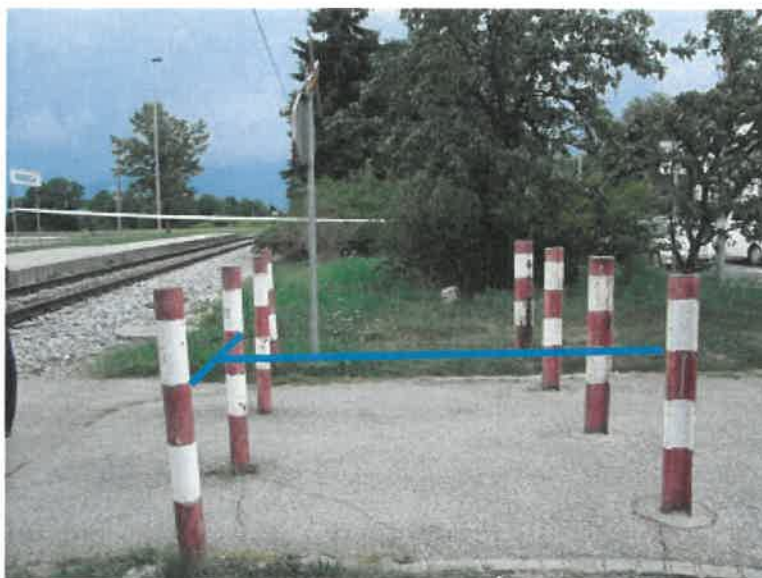
Slika št. 3: Modri črti ponazarjata zamik vgrajenih stebrov v posamezni vrsti pred nivojskim prehodom
