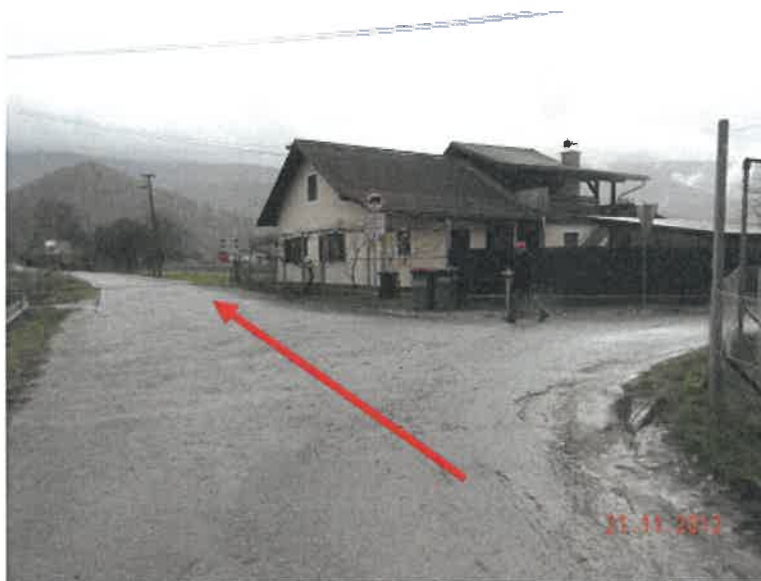
Slika št. 5: Prikaz preglednosti prehoda in cestno prometnih znakov – rdeča puščica označuje gibanje v nesreči udeleženega cestnega osebnega motornega vozilapo cesti, kjer pogled na progo v smeri postaje Ruše zakrivajo stavbe ob progi
