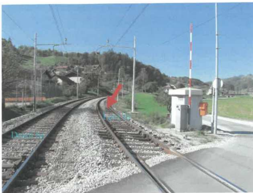
Slika št. 5: Prikazuje konfiguracijo terena ob ter na progi, na področju, kjer je vodja del hodil po levem tiru, rdeča puščica pa kraj povoženja
