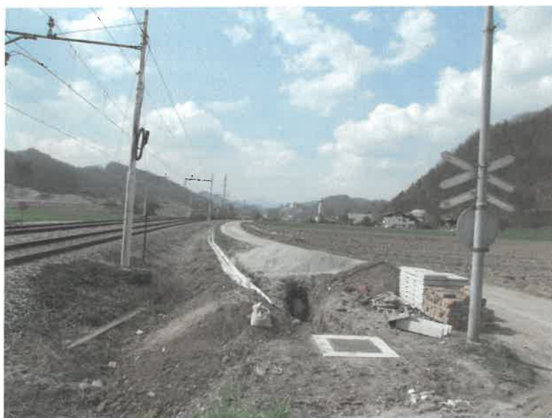
Slika št. 2: Prikazuje preglednost proge iz nivojskega prehoda proti Sevnici
