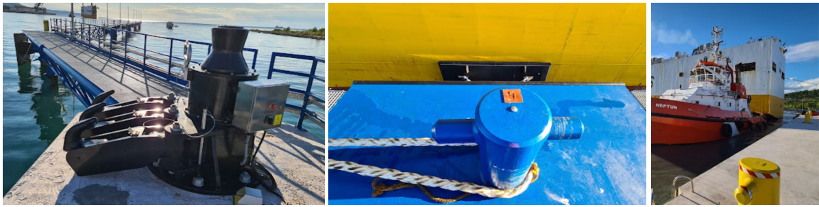
Slika 8: Kljuke na priveznih mestih (PM), privezniki na naslonskih pilotih (1-5) ter privezniki na obali (6-9)
