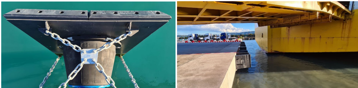
Slika 9: Odbojniki na naslonskih pilotih ter odbojniki na prekladalni rampi
