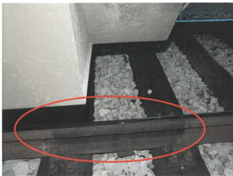
Slika št. 3: Rdeča elipsa označuje sledi potiskanja vlaka št. 38008 po trčenju do zaustavitve
