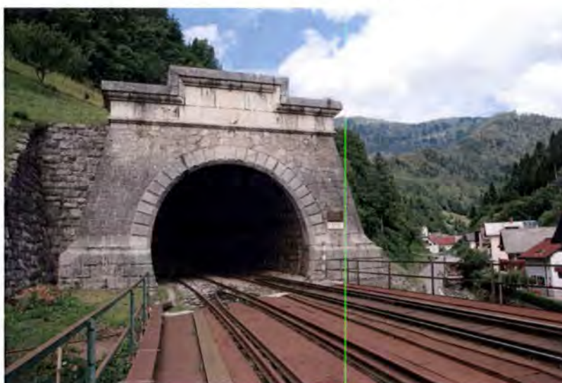
Slika 3-6: Južni portal predora Bohinj
