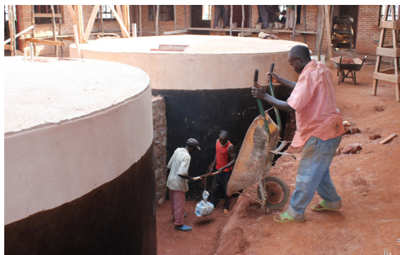
Gradnja vodnjakov na severu Burundija (Vir: Slovenska karitas)
