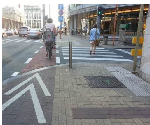
Slika 28 in 29: Primer nivojskega vodenja kolesarske steze (in prehoda za pešce) preko križišča z neprednostno cesto (Gregor Steklačič in Making space for Cycling)
