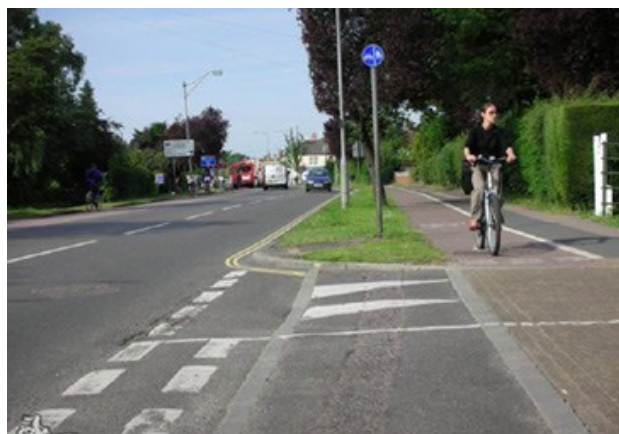
Slika 28 in 29: Primer nivojskega vodenja kolesarske steze (in prehoda za pešce) preko križišča z neprednostno cesto (Gregor Steklačič in Making space for Cycling)
