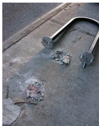
Slika 107: Poškodbe kolesarskih stojal in odpravljanje posledic vandalizma sodijo med tekoče vzdrževanje (Vir: StretBlog NYC)
