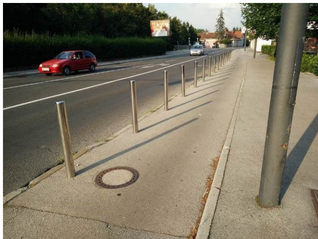
Slika 32: Konfini na kolesarskih stezi ožijo kolesarjev prometni profil. V primeru postavitve se prosti profil kolesarske steze meri od konfina in ne od roba pločnika.
