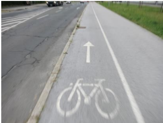
Slika 24: Kolesarska steza brez varovalnega pasu (odmik 0,5 m od robnika) (Lep et al.)
