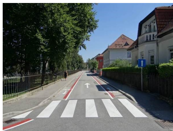
Potem: omogočeno kolesarjenje v obe smeri, ločena kolesarska infrastruktura, povečana preglednost v Slovenj Gradcu
