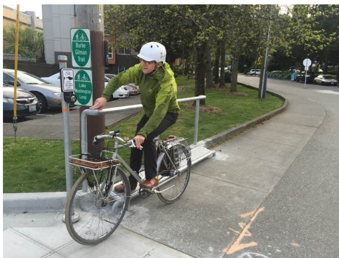
Slika 76: Držalo za kolesarje pred križiščem (vir: Seattle)
