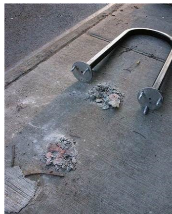
Slika 107: Poškodbe kolesarskih stojal in odpravljanje posledic vandalizma sodijo med tekoče vzdrževanje (Vir: StretBlog NYC)
