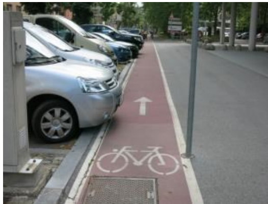
Sliki 25 in 26: Primer neustrezne izvedbe ločenih pasov za pešce in kolesarje (brez odmika med kolesarsko stezo in parkirnimi prostori - robnikom) (Lep et al.)
