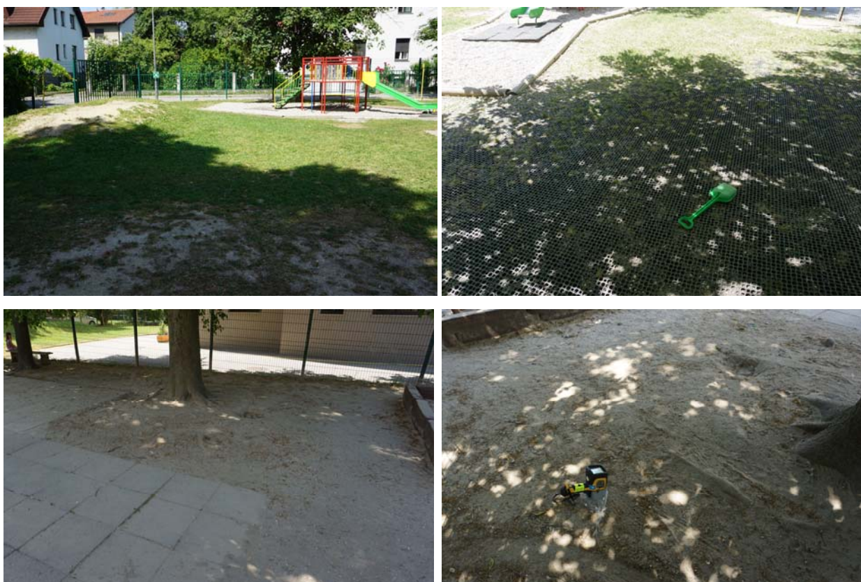
Slika 5: Gole površine na igrišču (sliki levo) rešujejo z rušnimi mrežami in pranim peskom (zgoraj desno) in delno z betonskimi ploščami (spodaj levo); neposredne meritve gole površine v senci pri peskovniku niso pokazale onesnaženosti površine igrišča, saj na površini prevladuje mivka iz peskovnika, ki jo redno obnavljajo pri čemer upoštevajo priporočilo o ustreznosti peska za peskovnike otroških igrišč
