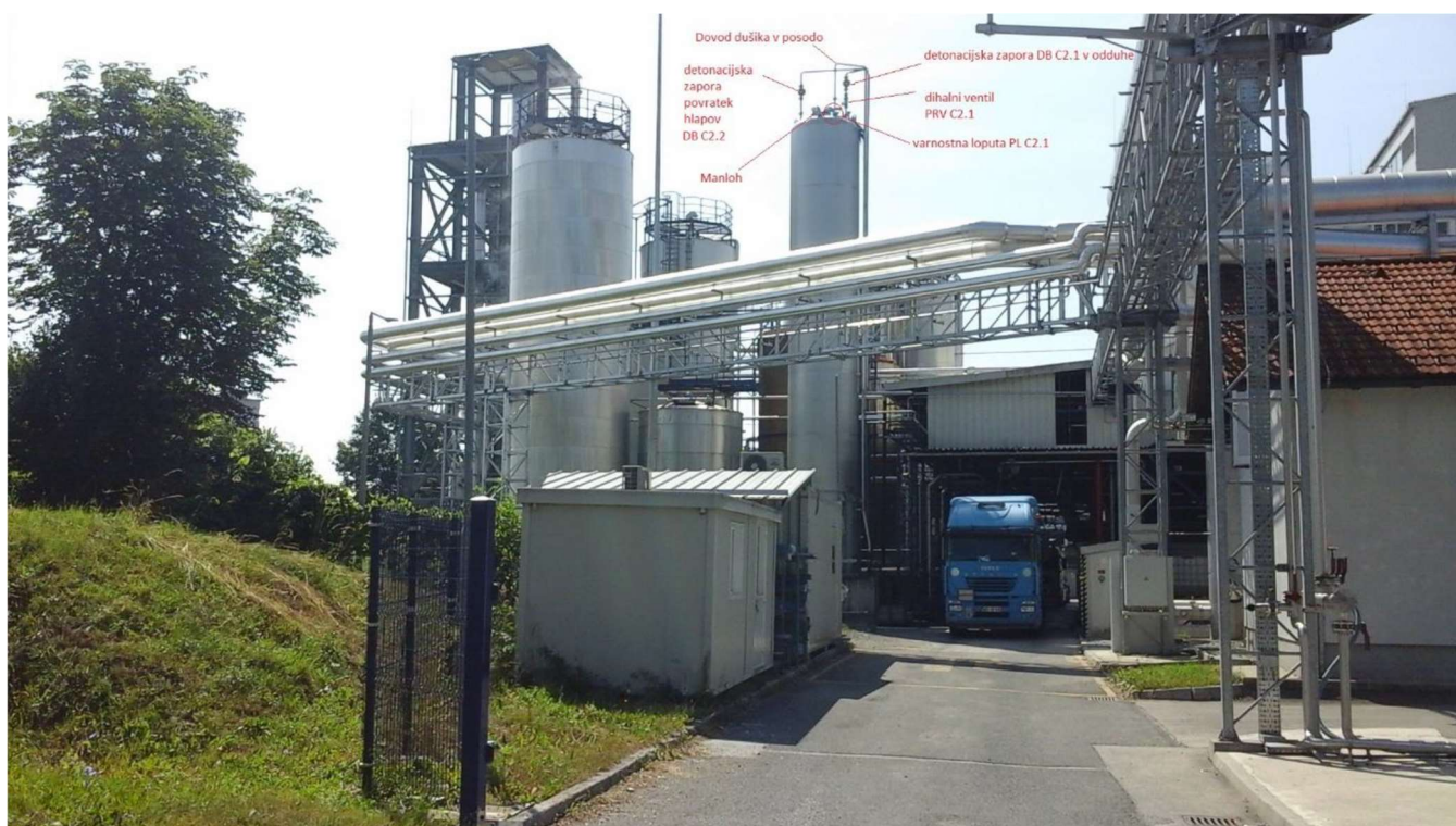
Slika 3: Pogled s severa na rezervoar C2, nadstrešek pretakališča in tovornjakom na pretakališču z dne 5.7.2019. Kasneje so zgradili še podest do rezervoarja C2. Vir: Poročilo Melamin/IJS/SIQ.
