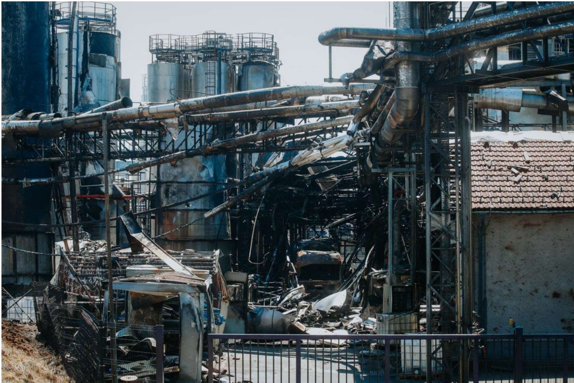
Slika 4: Pogled s severa na izhod iz pretakališča po dogodku. Rezervoarja C2 ni več, na sredini viden ostanek kabine kamiona, levo ostanki kontejnerjev pogodbenega izvajalca, spredaj vidna drsna vrata izhoda. Vir: 24ur.com.
