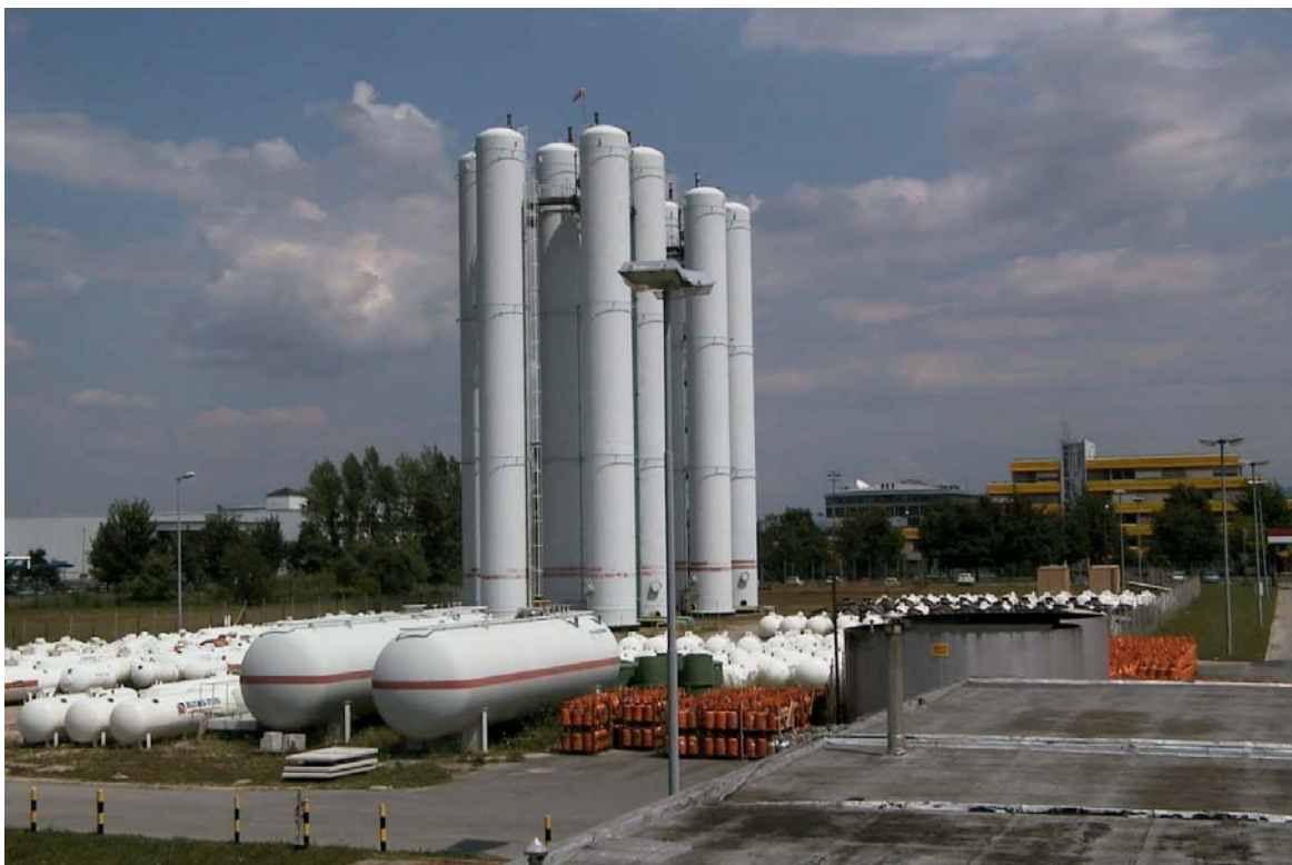
Slika 8: Fotografija vertikalnih rezervoarjev za UNP na lokaciji Butan Plin d.d..
