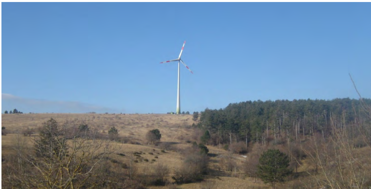
Slika 19: Vetrna elektrarna VEDV15, pogled od stavbe Dolenja vas 34B
