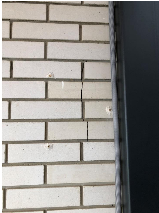
Slika 1: Deformetrični trikotnik na razpoki št. 81 za spremljanje delovanja razpoke.
