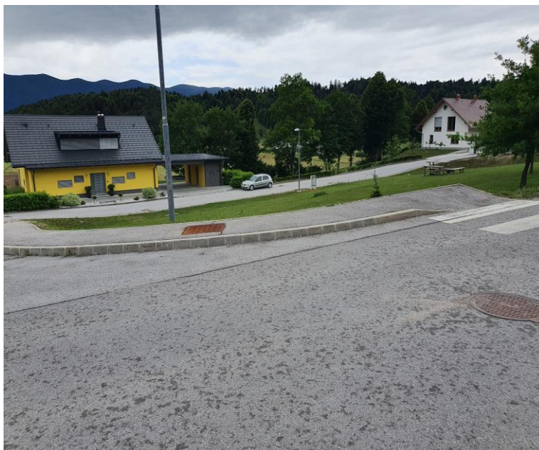
Slika 38: Pogled na poseg v olistanem stanju (vir: Google)
