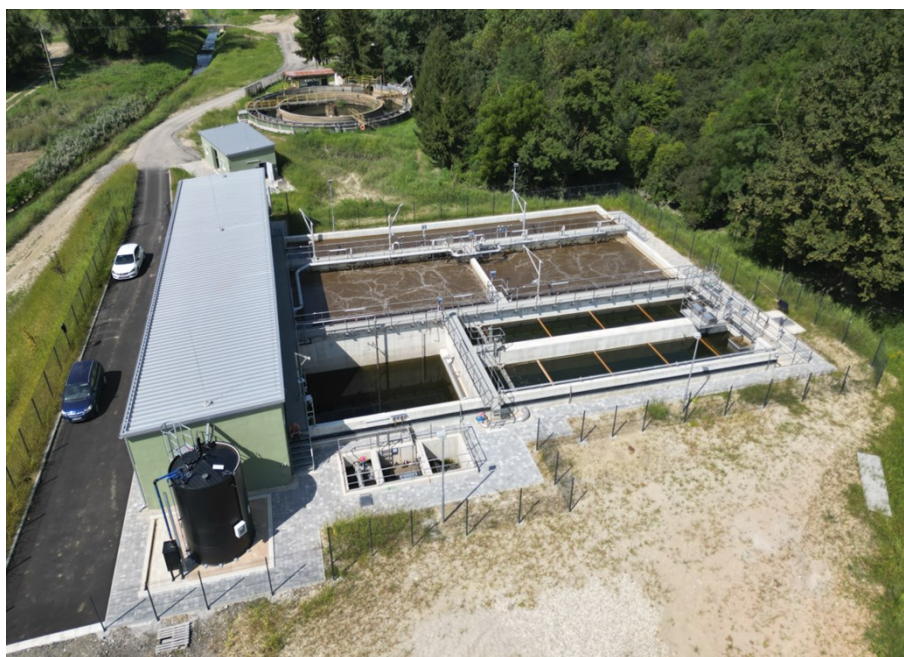
Slika 01: Kompaktna čistilna naprava občine Radenci z različnimi stopnjami postopka
