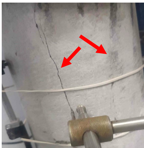
Slika 2: sub vertikalna primarna razpoka in sekundarna razpoka kot posledica obremenitve med preskusom (vzorec V-7, 3.1 - 3.4 m)
