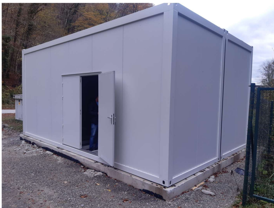
Slika 4: primer črpališča v kontejnerskem montažnem objektu
