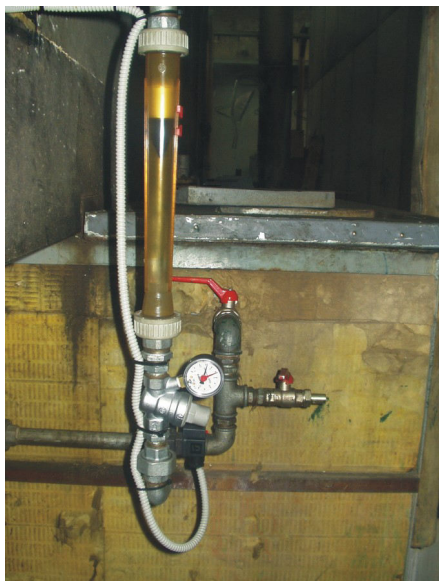
Slika 22: Merilec pretoka z regulatorjem tlaka na izpiranju.
