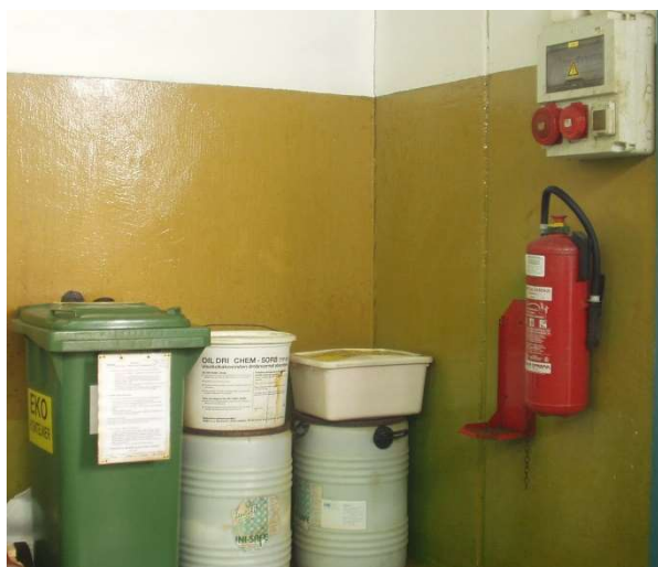
Slika 3: V čistilni napravi – Eko zabojnik z vpojnimi sredstvi in pripomočki za omejevanje razlitij
