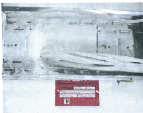
Slika 2: Označitev požarnega tesnenja preko sektorja.
