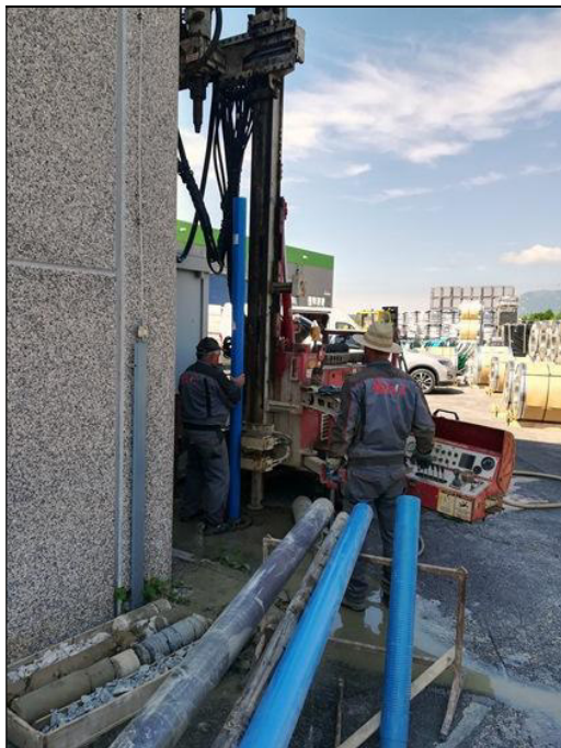
Slika 5. Vrtanje in cevljanje piezometra PL-2/21.
