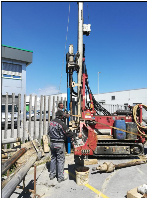
Slika 2. Vrtanje piezometra PL-1/21.
