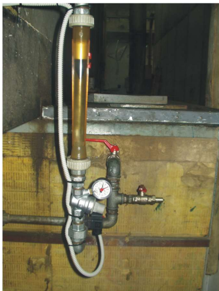
Slika 22: Merilec pretoka z regulatorjem tlaka na izpiranju.
