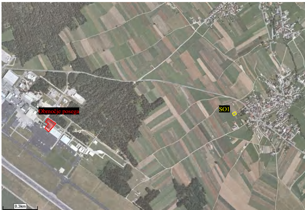
Slika 1.3.b: Informativni prikaz območja posega z označenim najbližjim objektom z varovanimi prostori [4] Legenda: rdeča obroba – parcelne meje posega, rumena obroba - najbližji stanovanjski objekt SO1 (Spodnji Brnik 96).
