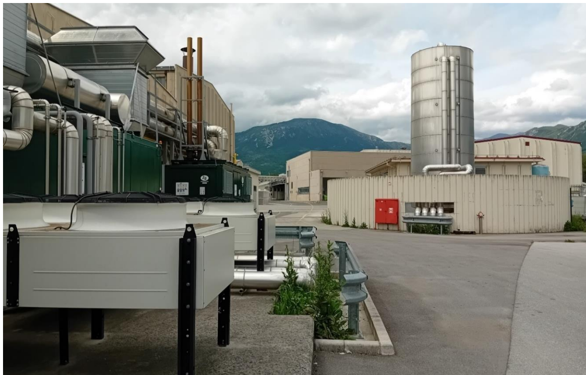
Slika 17: Kogeneracija (N49) z rezervoarjem v katerem se shranjuje segreta voda
