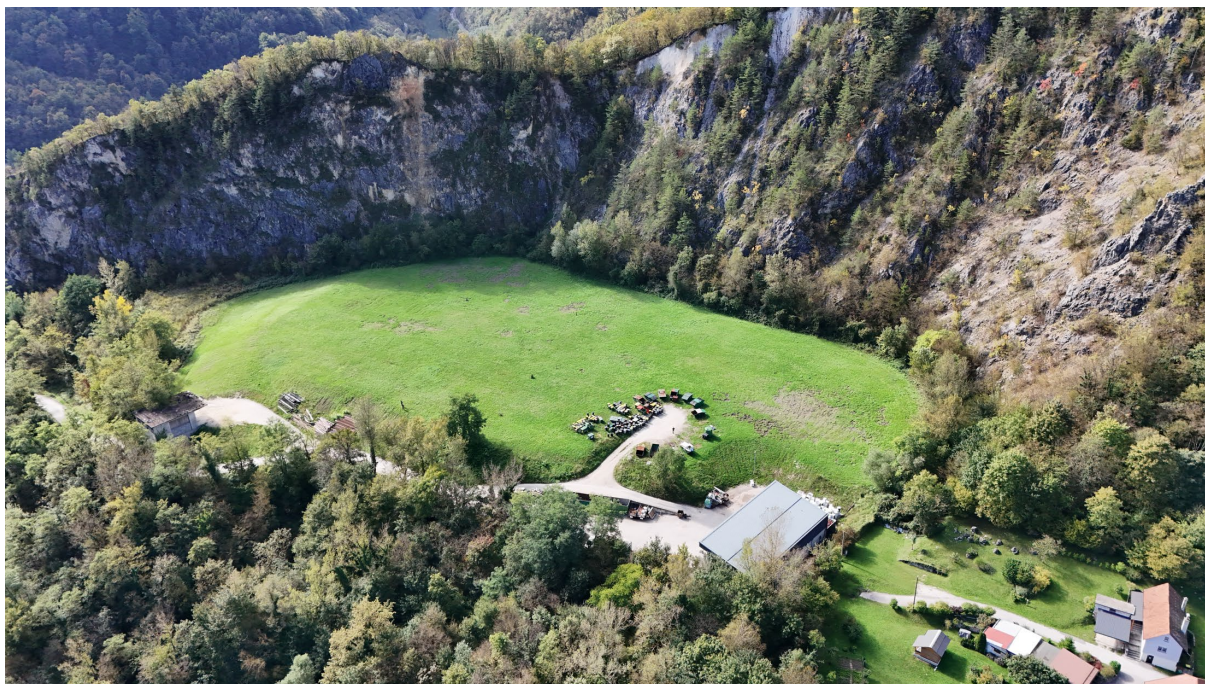
Slika 14: Pogled na območje zaprtega odlagališča s severovzhodne strani (Vir: arhiv HSE Invest d.o.o., julij 2025)
