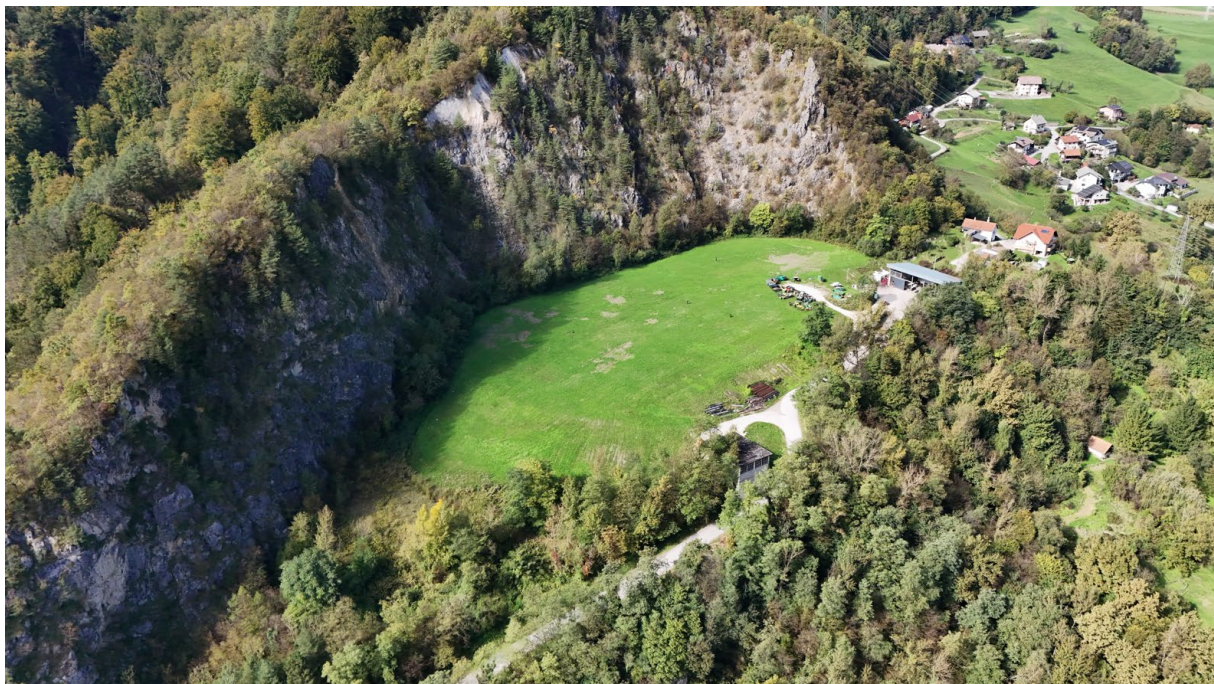
Slika 13: Pogled na območje zaprtega odlagališča z jugovzhodne strani (Vir: arhiv HSE Invest d.o.o., julij 2025)
