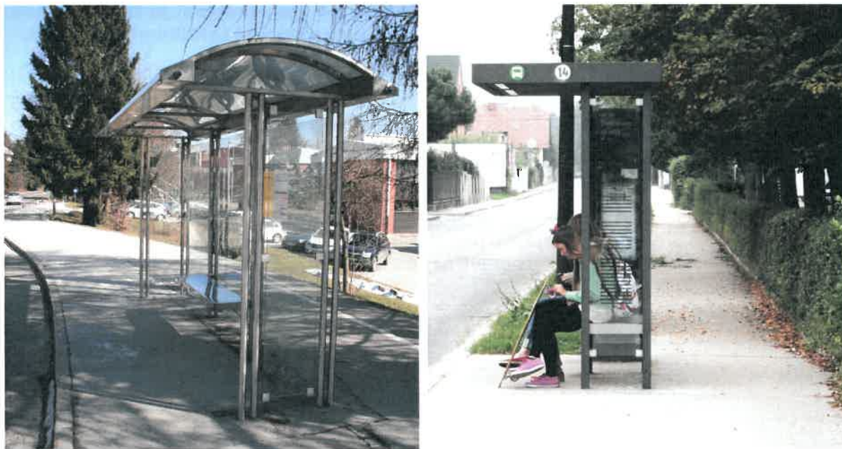
Slika 10: Oprema avtobusnih postajališč. 10a: Teško opazen nadstrešek. Nadstrešek je zaradi nekontrastnih materialov, ki se zlijejo z okolico, težko opaziti. Težavne so steklene stene, ki jih slabovidni ne vidijo, še posebej zaradi tega, ker nadstrešek stoji sredi peščeve površine. Opremiti bi ga bilo treba s kontrastnimi oznakami. 10b: Nadstrešek je ustrezno umaknjen s pešpoti in vizualno dobro kontrasten glede na tlak.
