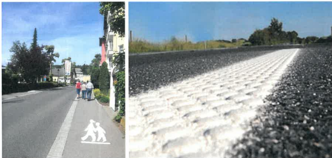
Slika 16: Označbe roba pasu za pešce morajo biti dovolj široke (priporočljivo 30 cm) ter taktilno in vizualno zaznavne. 16a: Pas za pešce z dovolj širokim taktilno zaznavnim robom iz granitnih kock. 16b: Taktilna ločilna črta iz hladne strukturne plastike. Če se za označbo uporablja taktilna ločilna črta iz materialov za debeloslojne označbe, mora biti zelo grobe strukture, neprekinjena in široka vsaj 20 cm (priporočljivo 30 cm).
