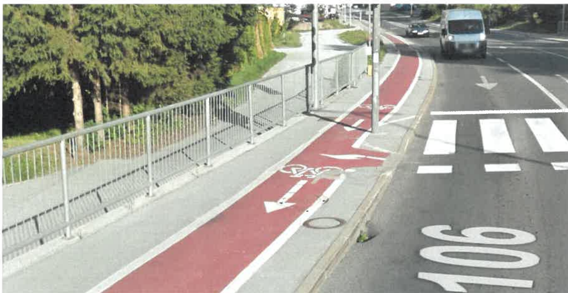
Slika 26: Primer (zelo pogoste) neustrezne umestitve kolesarskega pasu na pločniku – preozek pas za pešce. Minimalna širina poti, ki je predvidena s Pravilnikom o kolesarskih površinah (90 cm), je ustrezna samo v primerih kolesarskih površin in površin za pešce zunaj naselij. Tako ozka peščeva pot v naseljih je v nasprotju s temeljnimi državnimi dokumenti (kot je Uredba o prostorskem redu Slovenije, več na str. 24), saj pomeni občutno poslabšanje pogojev za hojo, pri tem pa so najbolj ogroženi funkcionalno ovirani uporabniki, ki potrebujejo spremljevalca (na primer slepi in slabovidni, gibalno ovirani, poškodovani in bolni ter starši z majhnimi otroki). Glej tudi sliki 4 in 13.
