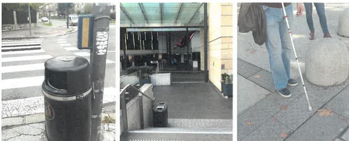
Slika 31: Neprimerna postavitev urbane opreme. Oprema naj bo postavljena tako, da ne ovira prehoda in uporabe pripomočkov. 31a: Smetnjak ovira slepe pri uporabi zvočnega semaforja. 31b: Neprimerna postavitev smetnjaka na stopnišču. Stopnice so ustrezno označene in opremljene z ustreznim oblikovanim prijemalom. Označene so tudi s taktilnimi oznakami, vendar so težko dostopne zaradi smetnjaka, ki ovira vse uporabnike, ki si pri hoji po stopnicah pomagajo z oprijemalom. 31c: Neprimerna postavitev ovire za preprečevanje dovoza na taktilno oznako. Ovire na sliki so ene najbolj težavnih za slabovidne, saj so zelo slabo kontrastne, zelo težko opazne pa so tudi zaradi svoje neizrazite oblike.
