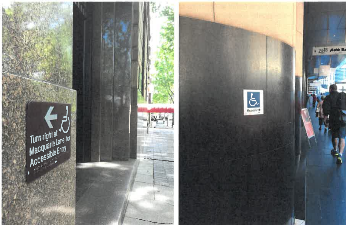
Sliki 35a, b: Primera označitev dostopne poti s standardnim znakom za invalide. Znaki morajo biti postavljeni tako, da lahko oseba na vozičku samostojno najde pot od točke, kjer se dostopna pot za invalide loči od glavne poti, do točke, kjer se poti spet združita.
