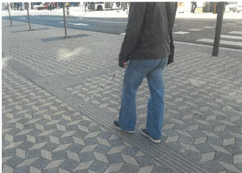
Slika 33: Primer ustrezno načrtovanega kompleksnega taktilnega vodenja v območju višje stopnje dostopnosti. Taktilna vodilna linija v kombinaciji s čepastimi oznakami je ustrezno izvedena ob upoštevanju lokacij zvočnih semaforjev in povezana z robovi. Tako slepemu pešču omogoča varno pot po pomembni ulici. Opomba: vizualni kontrast ni ustrezen, zato je linija manj uporabna za slabovidne.
