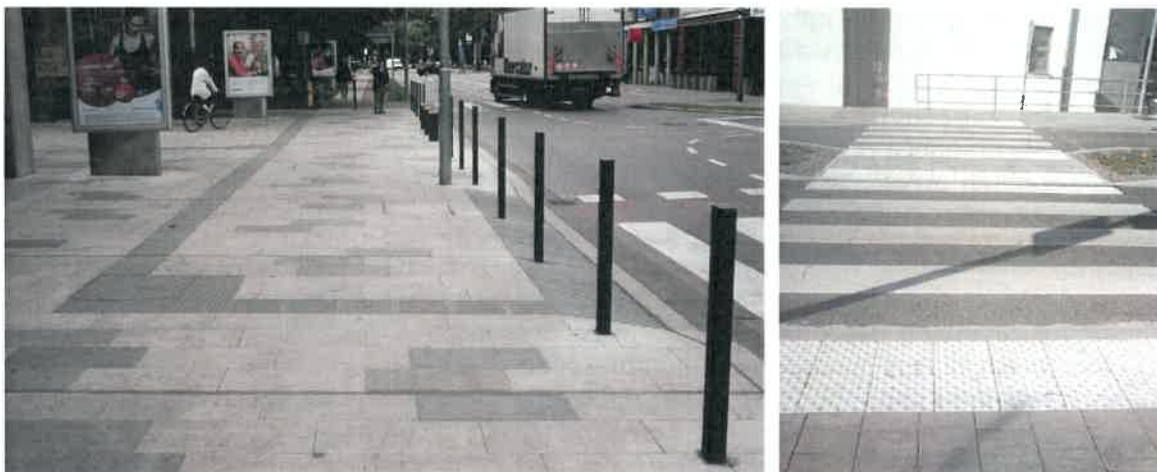
Slika 34: Razlika med prehodom za pešce v območju višje stopnje dostopnosti (34a) in prehodom za pešce v območju osnovne stopnje dostopnosti (34b). 34a: Taktilne oznake povezujejo prehod za pešce z vodilnimi robovi (na primer rob poti, fasada objekta). 34b: Taktilne oznake zagotavljajo samo osnovno varnost pešca – opozarjajo na rob ceste.
