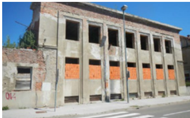
Slika 6: Stavbno zemljišče, ki ne opravlja več svoje prvotne funkcije in je razvrednoteno (avtorica fotografij: Barbara Lampič).
