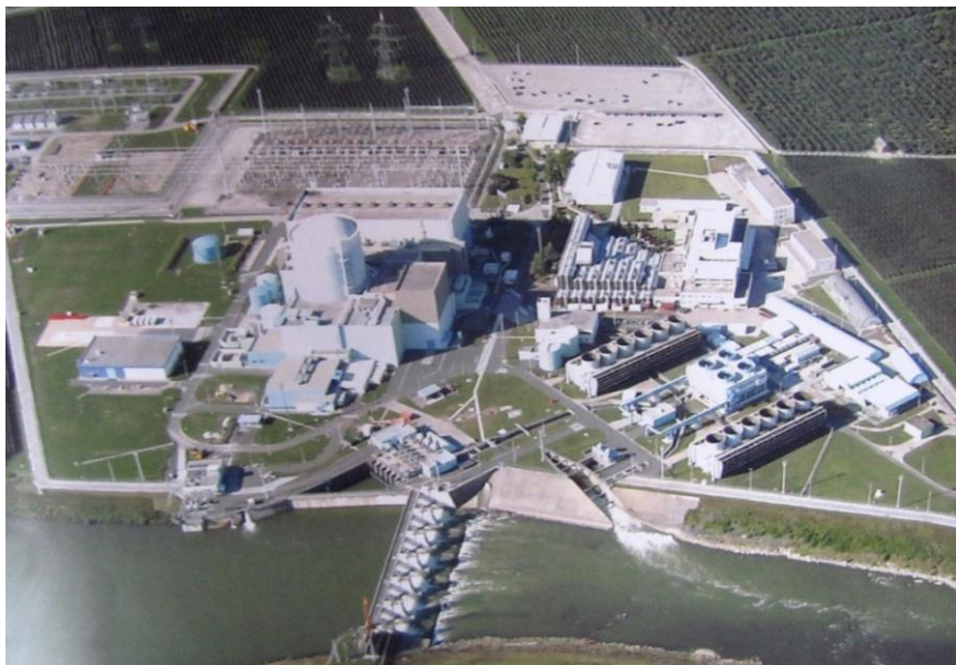
Slika 59: NEK – ZAJEZITEV SAVE S PREGRADNIM OBJEKTOM ZA ZAGOTAVLJANJE UHS
