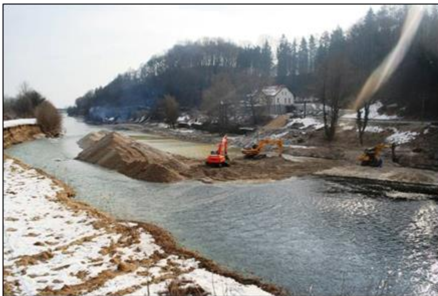
Slika 75: PRIMER PREOBLIKOVANJA STRUGE OB SANACIJI ERODIRANE LEVE BREŽINE KRKE DOLVODNO OD JEKLENEGA MOSTU (FOTO MOHOR SLATNER, 2006)
