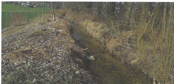
Slika 5: Stiški potok gorvodno od lokalne ceste od Marofa proti Rupam.
