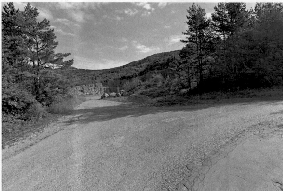
Slika 1.3.2.a: Pogled na obstoječi kamnolom Gabrovec pri uvozu na območje kamnoloma (29)
