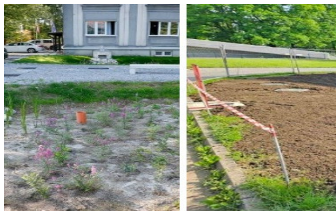
Slika 19: Primer deževnega vrta na Hajdrihovi ulici v Ljubljani (Zupan, 2025; foto: Luka Kotnik, levo) ter zadrževalno-ponikovalnega polja pri Tivoliju (Zupan, 2025; foto: Matej Radinja, desno).
