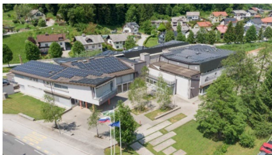
Slika 15: Primer sončne elektrarne, nameščene na strehi osnovne šole v občini Ivančna Gorica (foto: Gašper Stopar, Občina Ivančna Gorica).
