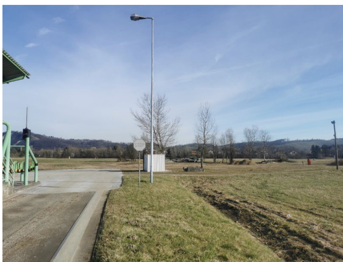
Slika 3: Osrednji del zaprtega odlagališča Pobrežje z elektrarno (Vir: arhiv HSE Invest d.o.o., marec 2023)
