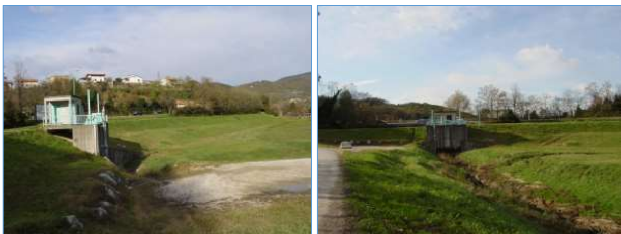
Slika 189. Prikaz protipoplavnega ukrepa – suhi zadrževalnik Pikolud.
