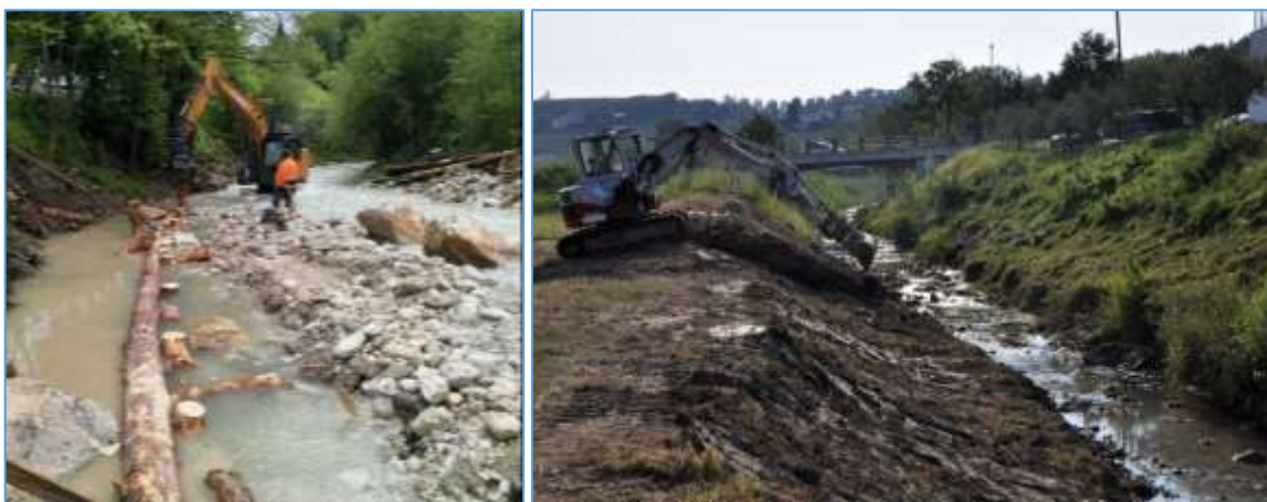
Slika 191. Redno vzdrževanje vodotokov.
