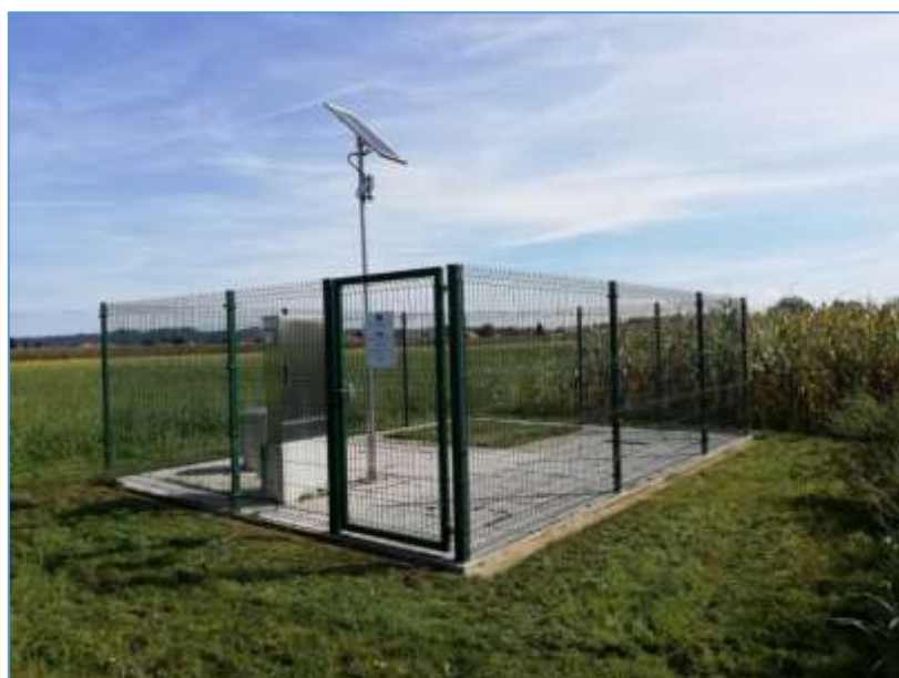
Slika 179. Vodomerna postaja za podzemne vode ARSO.
