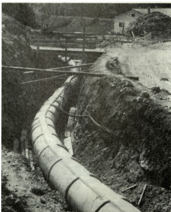
Slika 5: Gradnja dovodnega sistema reke Radovne v Blejsko jezero, prednapeta armiranobetonska cev
