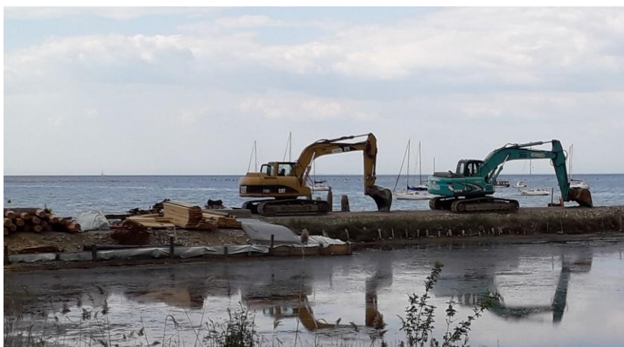
Slika 2-104: Sanacija nasipa v Strunjskih solinah (foto: Tina Kirn)
