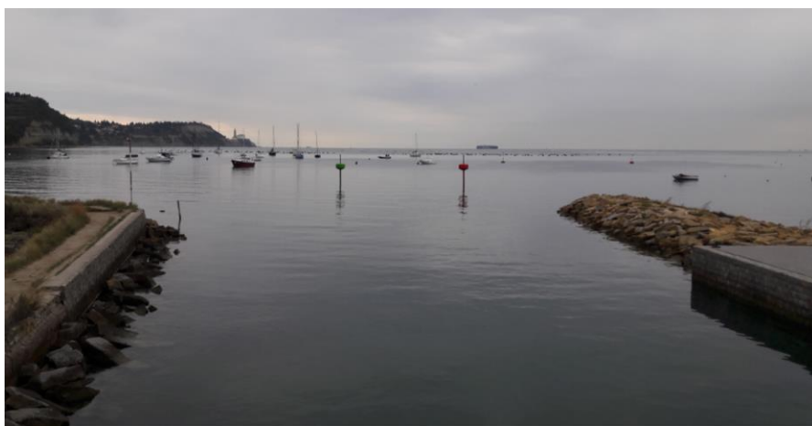
Slika 2-105: Poglabitev vplovitvenega kanala ob obnovi ribiškega pristanišča Strunjan (foto: Tina Kirn)
