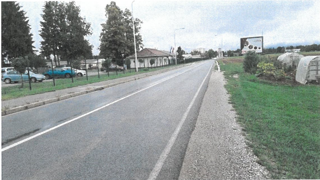
Slika 3: na R2-410/1135, km 0,700, pogled proti centru Kranja
