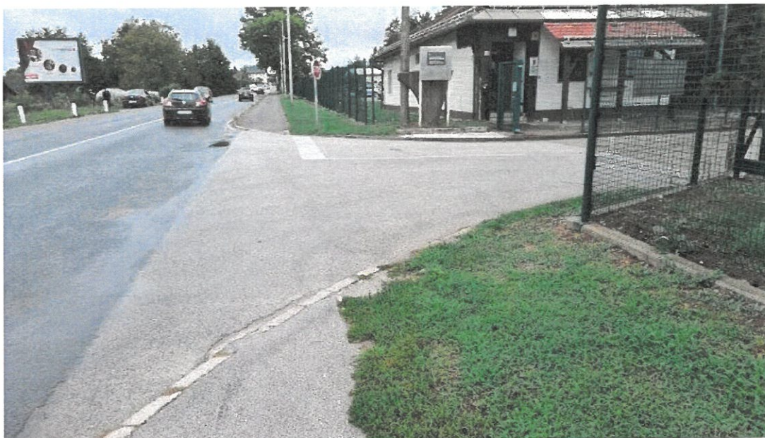
Slika 5: na R2-410/1135, pogled v smeri Kokrice, cestni priključek v km 0,810
