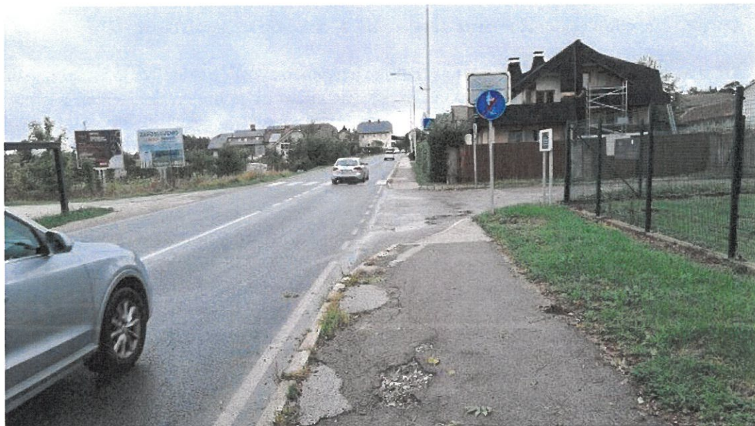
Slika 4: na R2-410/1135, pogled v smeri Kokrice, cestni priključek v km 0,620
